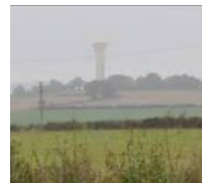
Château d'eau de Loiré
