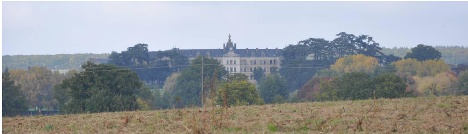
Collège de Combrée, particulièrement présent dans le paysage
