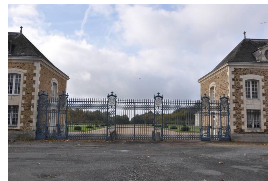
Entrée principale du château de Saint-Mars-la-Jaille
