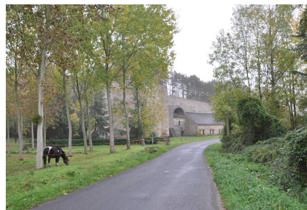
Usine à chaux de la Verrière (vue d'ensemble et détail)
